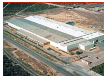
■ BES Завод 47 Испания - Sagunto - 21,500 м²
