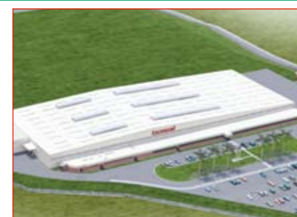
■ BDB Завод 50 Бразилия - Sao Paulo - 15,800 м² Строительство нового завода открывается в 2008.
